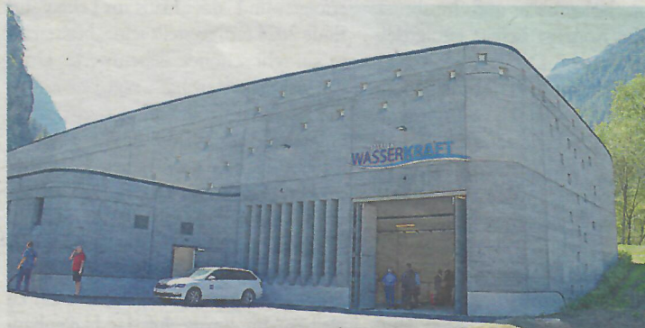
Die Anwesenden erhielten auch Zugang zum neu errichteten Wasserkraftwerk Tumpen Habichen.
