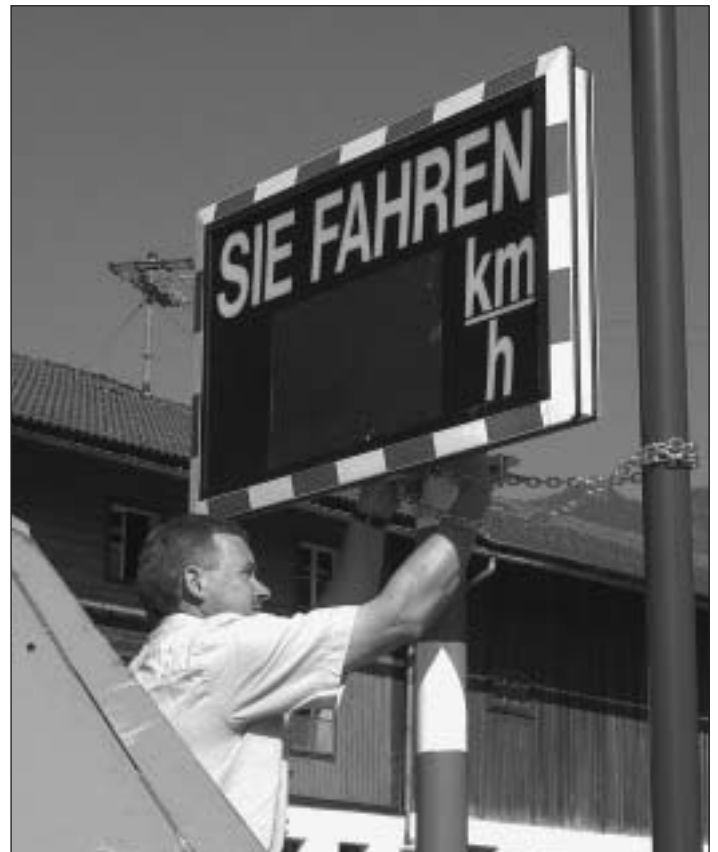
Bauhof-Mitarbeiter Peter Payr montiert die mobile Tempoanzeige.
