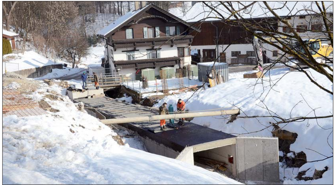
Im Bereich „Lampert“ fließt jetzt das Wasser jetzt in einer 58 Meter langen Beton-Künette. Mittlerweile führt hier wieder die Straße über den Bach.
