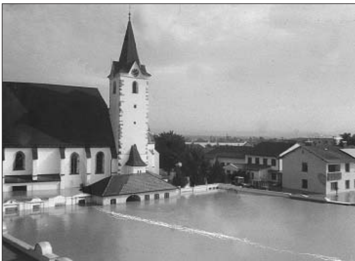
Mitterkirchen zur Zeit des Hochwassers: Friedhof, Kirche, Pfarrheim und Pfarrhof waren überflutet. Die Schäden sind gewaltig, die Sanierungsarbeiten werden noch Monate dauern. Und jeder Euro an Spenden wird in der Gemeinde dringend gebraucht.
