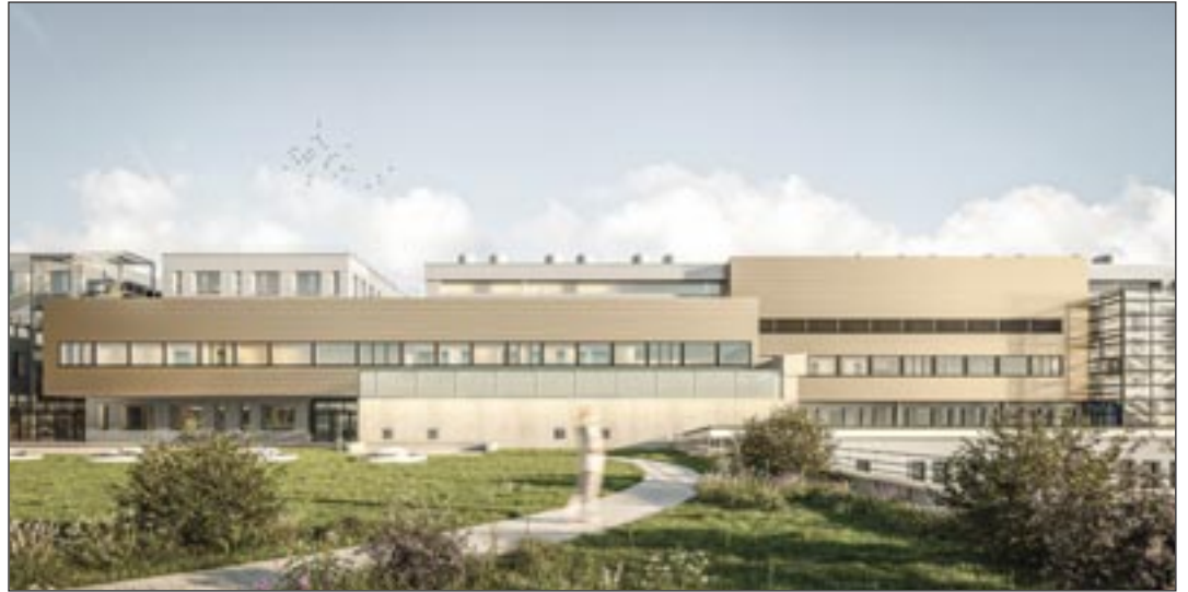
Am 28. August erfolgte der offizielle Spatenstich und damit der Startschuss für mehrere verschiedene Bauprojekte am Bezirkskrankenhaus Kufstein.
