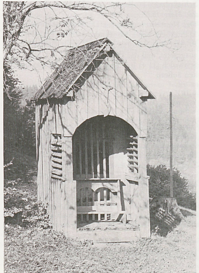
Die hölzerne, am Waldrand stehende „Aufinger-Kapelle“
