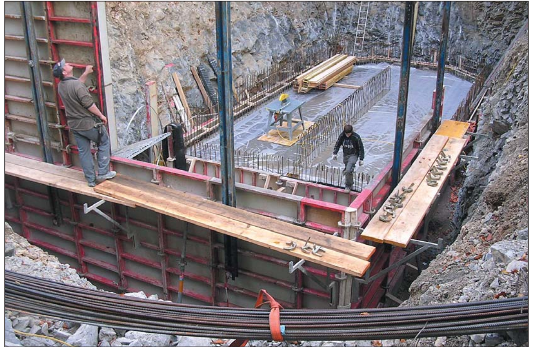
Der Bau des neuen Hochbehälters Ried wird die Wasserversorgung der Gemeinde weiter absichern.
