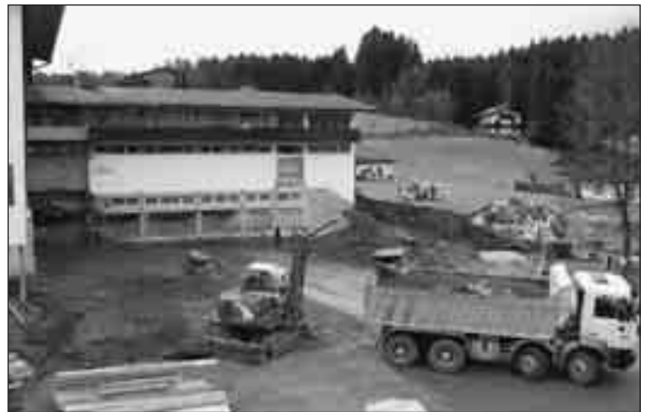
Auch am Schulgebäude wird mit Hochdruck gearbeitet.
