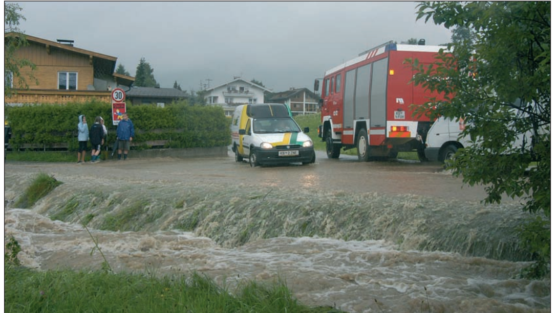
Beim Bachwirt zerstörte das Wasser die Querung, schoss über die Straße und überflutete die Garagen.
