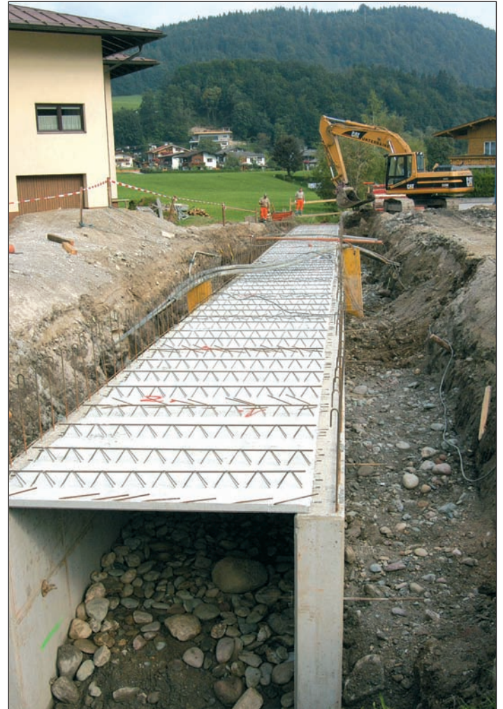
Im Bereich Bachwirt wurde eine neue Querung errichtet, die künftigen Hochwässern standhalten sollte.
