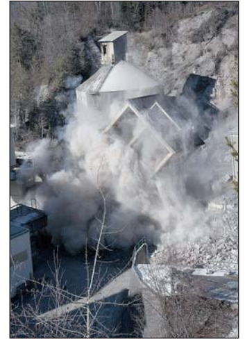
Mit 75 Kilogramm Sprengstoff wurde der 50 Meter hohe Turm im SPZ- Zementwerk Eiberg dem Erdboden gleich gemacht.
