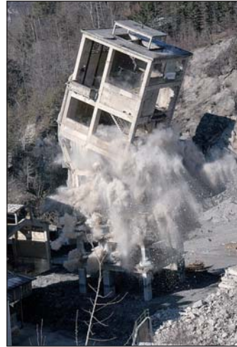
Mit 75 Kilogramm Sprengstoff wurde der 50 Meter hohe Turm im SPZ- Zementwerk Eiberg dem Erdboden gleich gemacht.
