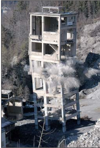
Mit 75 Kilogramm Sprengstoff wurde der 50 Meter hohe Turm im SPZ- Zementwerk Eiberg dem Erdboden gleich gemacht.
