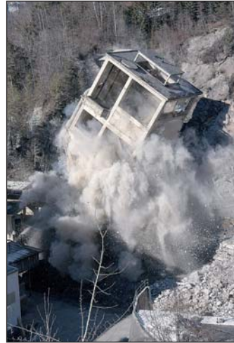
Mit 75 Kilogramm Sprengstoff wurde der 50 Meter hohe Turm im SPZ- Zementwerk Eiberg dem Erdboden gleich gemacht.
