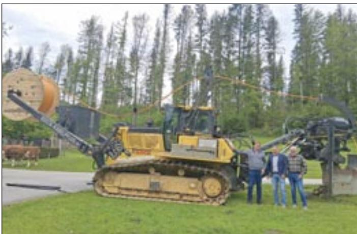
DER BREITBAND-AUSBAU in der Gemeinde Schwoich geht zügig voran. Die Arbeiten durch den Kabelpflug (Bild) konnten innerhalb der geplanten Zeit von drei Wochen von Amberg bis Achrain und Richtung Egerbach abgeschlossen werden. Somit wurden die Hauptstrecken verrohrt und für das Einblasen der Glasfaser vorbereitet. Bgm. Peter Payr, Vizebgm. Martin Gschwentner und GR Andreas Mayer (im Bild oben) sind mit dem Fortschritt jedenfalls zufrieden.
