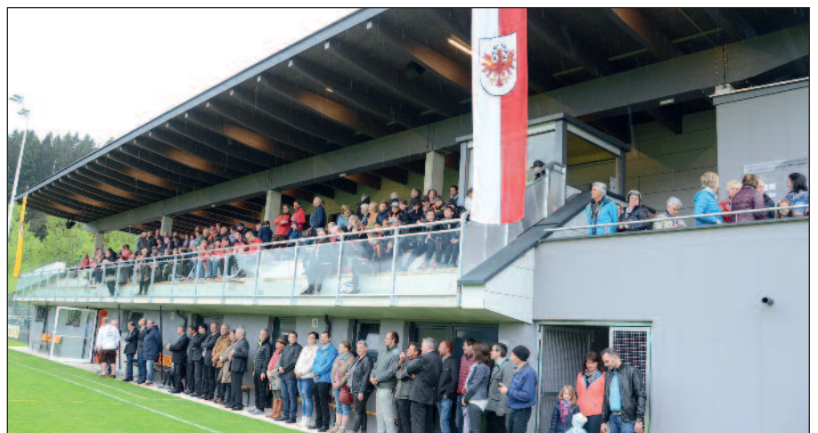
Das neue Vereinsgebäude des FC Schwoich wurde am 7. Mai offiziell eröffnet.
