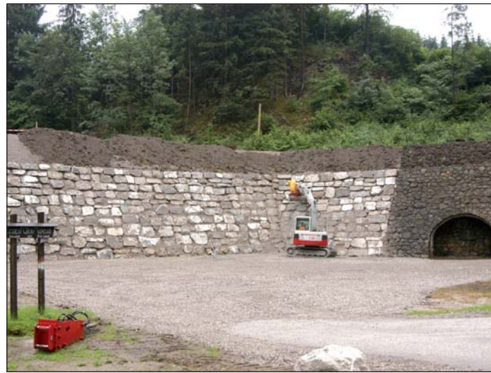
Zwischen den beiden restaurierten Brennöfen wurde zur Hangsicherung eine Steinmauer errichtet.
