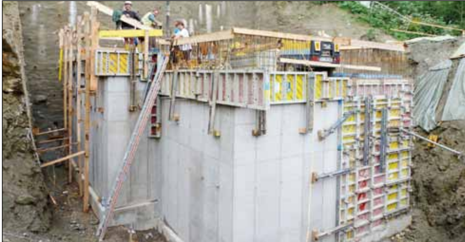
Bau Wasserkammern Hochbehälter „Kalte Kendl“
