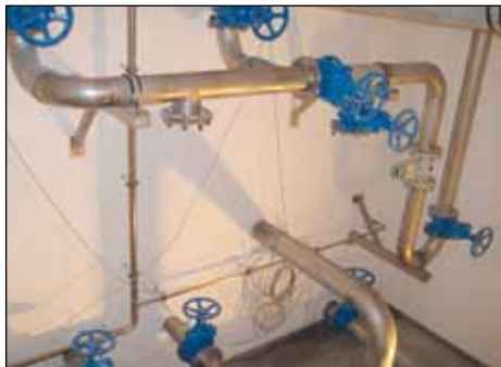
Verrohrung während der Bauarbeiten
