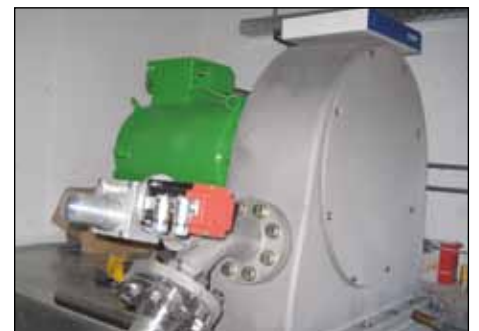
Einbau des Generators für die Stromerzeugung
