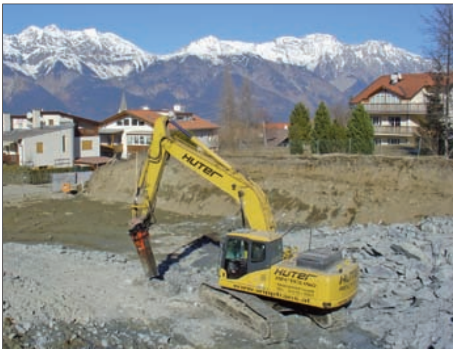
der Bau beginnt mit einem großen Loch
