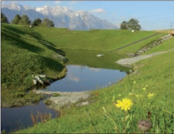
Das Retentionsbecken am Wendlweg
