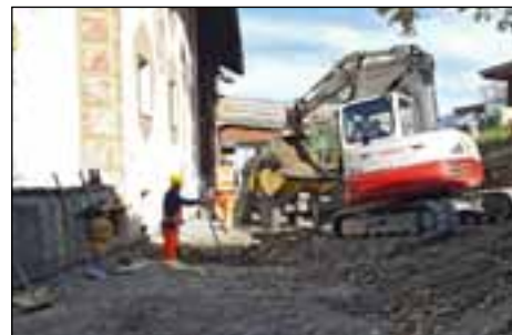
Straßensanierung Oberdorf © Josef Kotler
