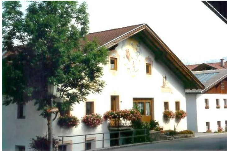
Wendl-Hof, ehemals Bundeshof Wohnhaus von Lüftlmaler Rudolf Winkler
