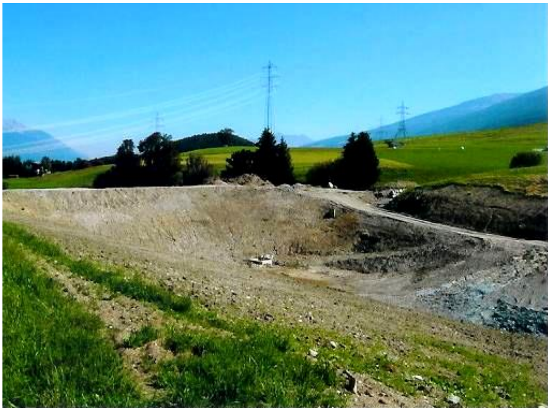
Retentionsbecken fast fertig
