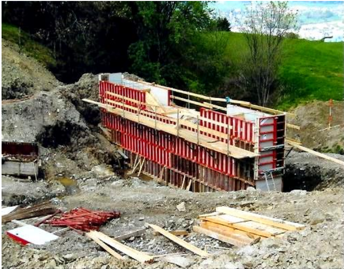
Innenleben im Auffang-Damm
