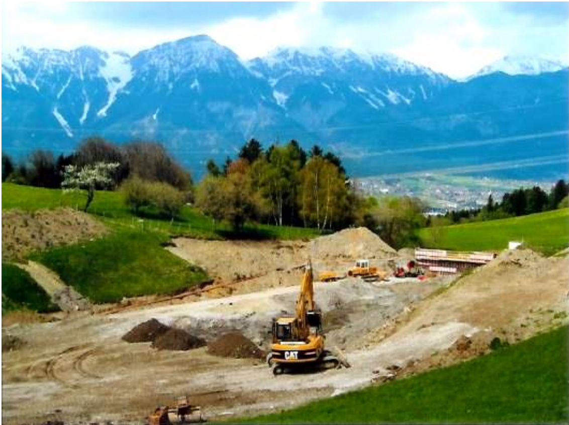
Bagger-Arbeiten im Auffangbecken Mühlthal
