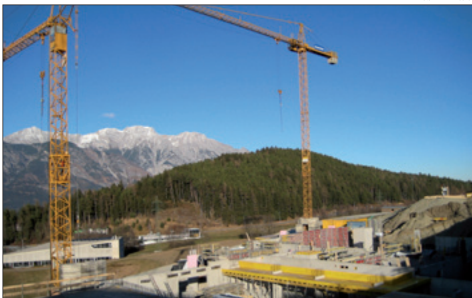
Bauarbeiten an der Tiefgarage Foto: Gemeinde Sistrans
