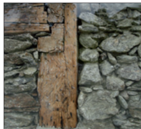
Tragende Holzkonstruktionen wurden mit Steinen ausgemauert Fotos: Toni Triendl
