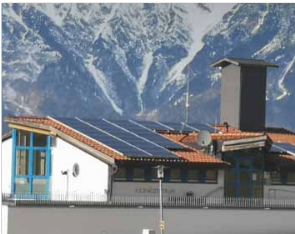
Photovoltaikanlage auf der Turnhalle und dem Feuerwehrhaus
