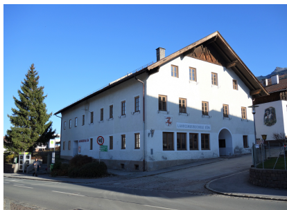
Altes Schul- und Gemeindehaus
