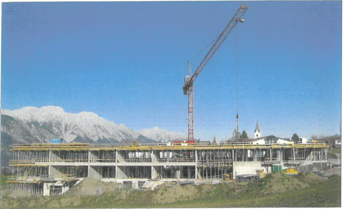
Der Bau in vollem Gange
