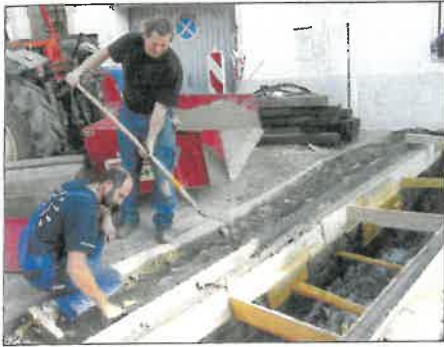
Sanierung Bachabdeckung
