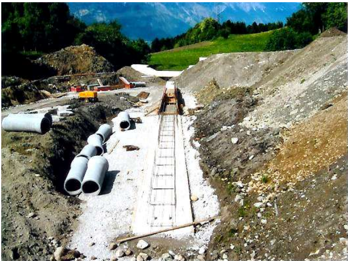
Auffangbecken Mühlthal: Was man nicht mehr sieht
