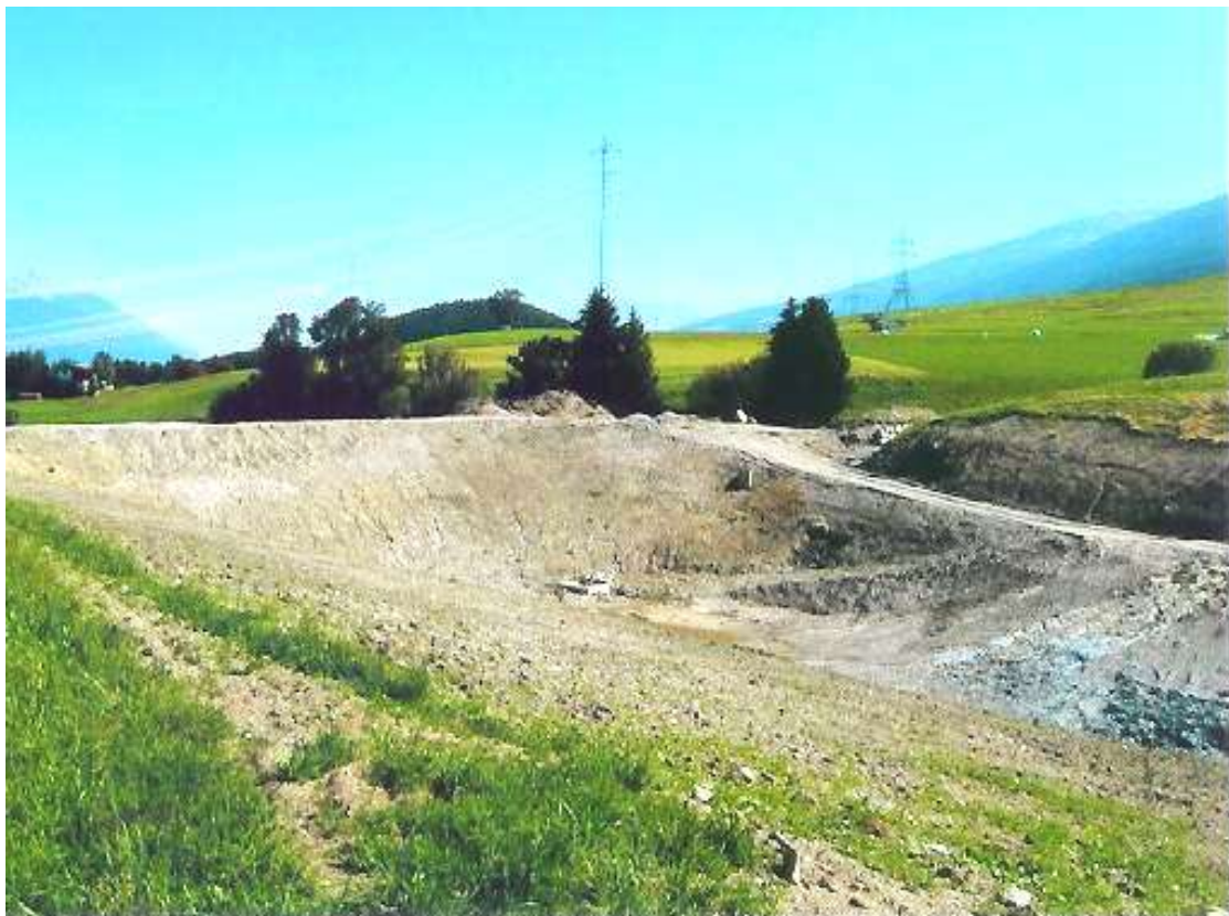
Retentionsbecken fast fertig
