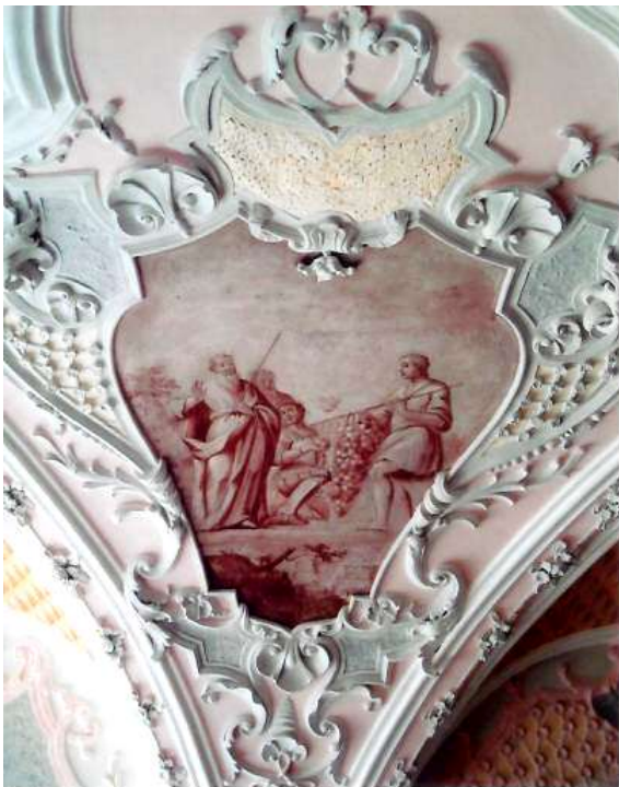
Gelungene Restaurierungsarbeiten von 2008
