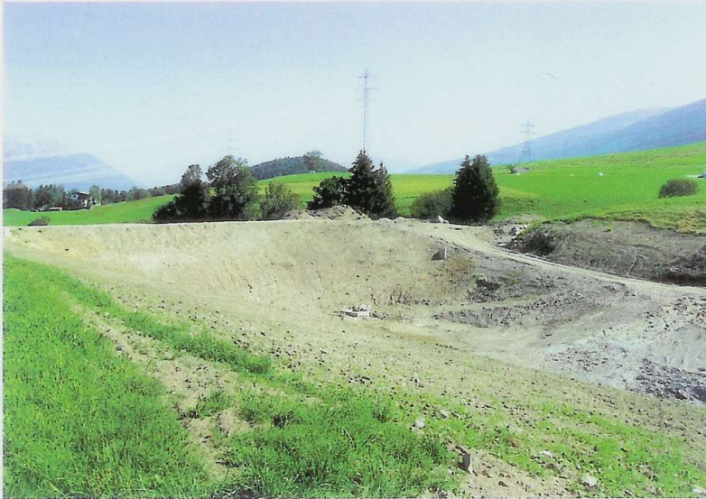
Das neue Retentionsbecken
