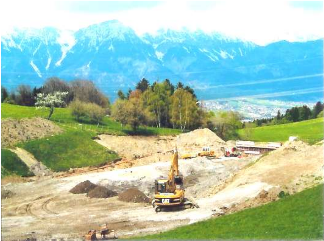
Bagger-Arbeiten im Auffangbecken Mühlthal
