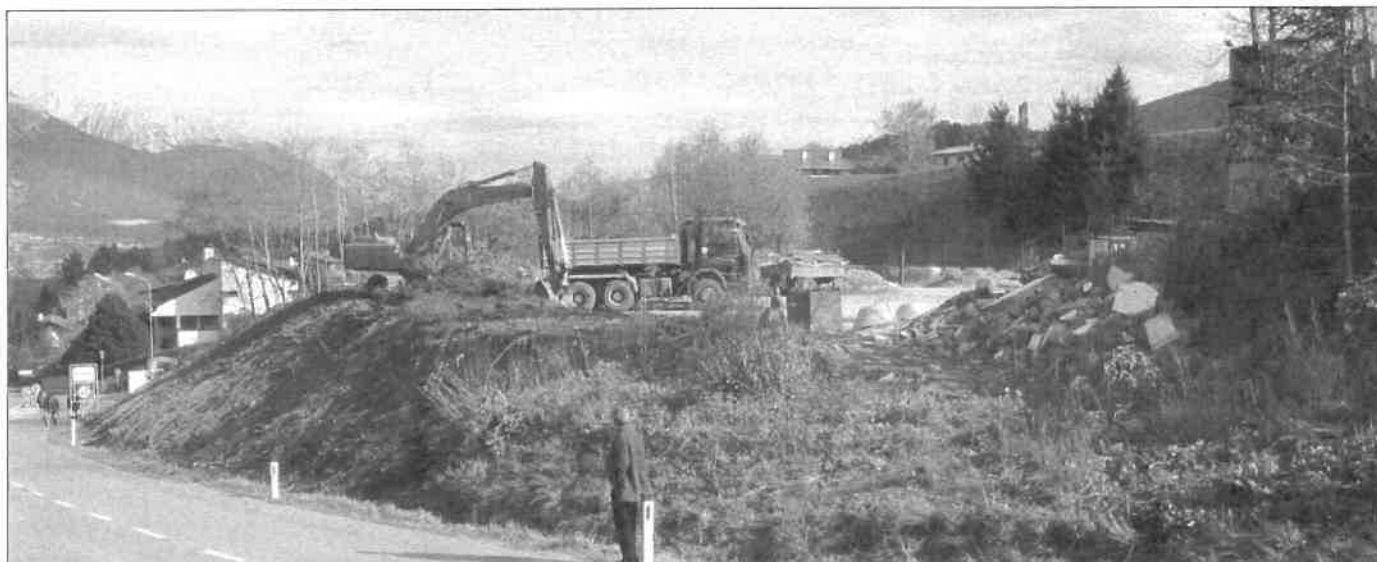
Der Bau des Recyclinghofes hat begonnen
