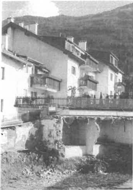
September 2001: Abbruch der Tischlerei Jenewein
