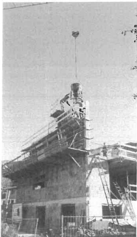
12.1.2002 Betonieren bei - 18 Grad Celsius
