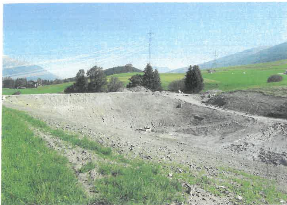
Das neue Retentionsbecken
