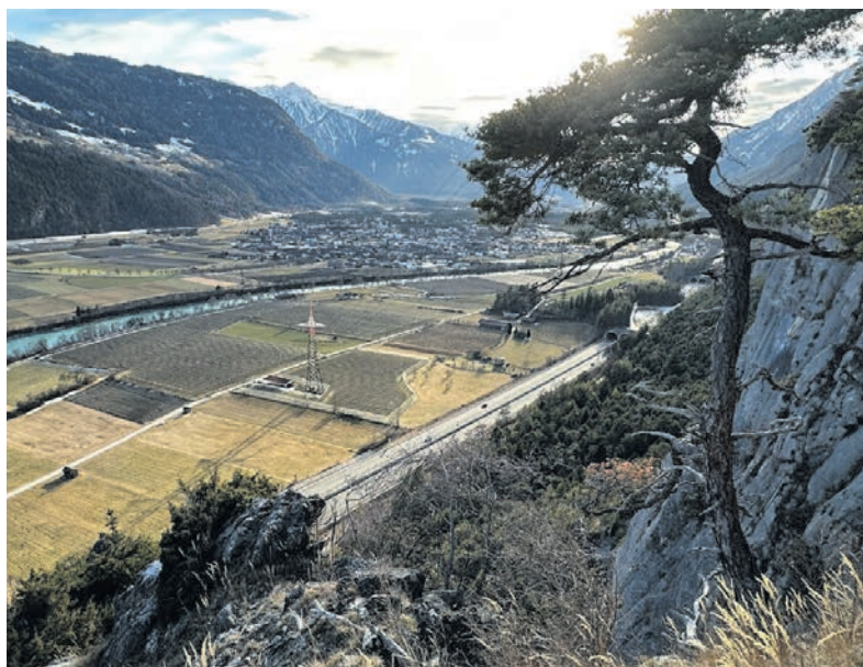
Die Vorarbeiten zum Kraftwerk Imst-Haiming haben begonnen.
