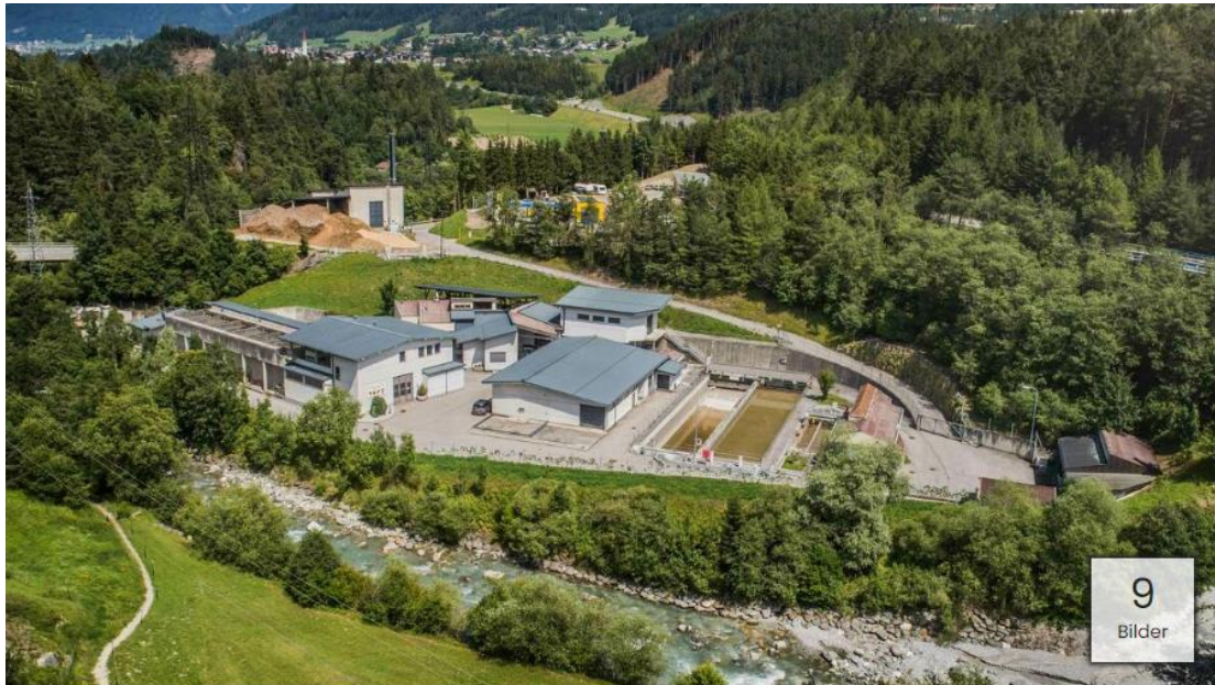
Auf dem Areal der Kläranlage wird eine Pumpstation errichtet, um die Stubaier Schmutzwässer über einen neuen Kanal nach Innsbruck schicken zu können. Foto: Lukas Pfurtscheller hochgeladen von Tamara Kainz
