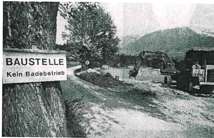
romantische Insel wurde erhalten, sie dient auch den schwachen Schwimmern zum Ausrasten. Wegen des steigenden Grundwasserspiegels konnten die Aushubarbeiten nur in Etappen durchgeführt werden, daher auch die lange Ausbauphase. 30.000 Kubikmeter Schotter wurden ausgehoben, dazu mußten zwei Bagger, zwei Mulden-
