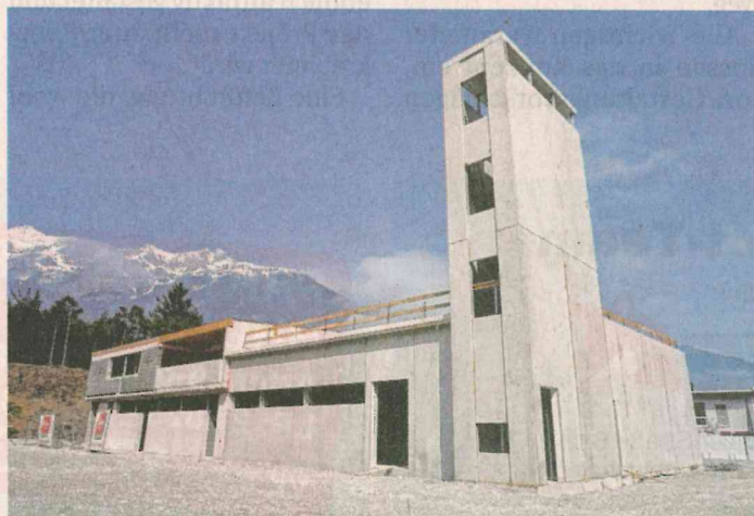
Das Feuerwehrhaus in Vomperbach nimmt immer mehr Form an. Bereits vor zwei Wochen konnte sich der Rohbau sehen lassen.
