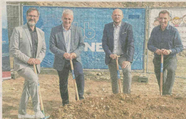
Spatenstich mit Bürgermeister Florian Gartlacher (m.), Vize-Bgm. Hans Hußl, Architekten Michael Heinlein und Alois Zierl.
