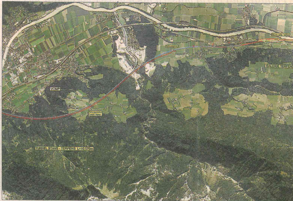
Die rote Linie zeigt den Verlauf der Unterinntaltrasse. Gut sichtbar der Ausgangspunkt der Bauarbeiten – die Schottergrube in Vomp.
