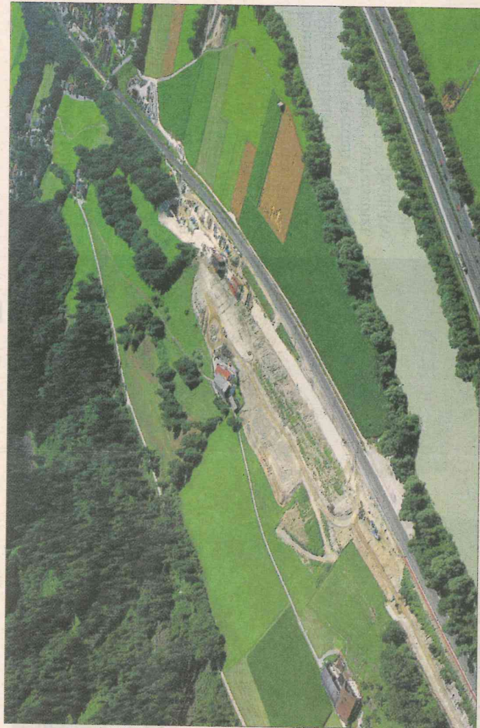
Größte Baustelle Westösterreichs: die Unterinntaltrasse (Bild: bei Terfens). Foto: BEG/Alpine Luftbild
