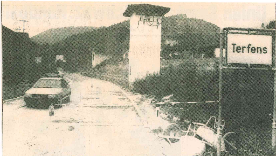
TERFENS (H.H.). — Im Bereich der Ortschaft und der Landstraße Terfens wird die Straße verbreitert und mit Gehsteig versehen (Bild). Ein Beitrag zur Verkehrssicherheit, dessen Ausgaben sich lohnen. Daher wird auf der ganzen Strecke der Verkehr durch die Straßenarbeiten zur Zeit behindert. Verständnissvoll zeigen sich die Verkehrsteilnehmer und Anrainer angesichts der Straßenverbesserung... Foto: Hintner
