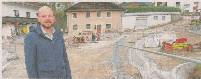
Noch herrscht Baustellentätigkeit am Dorfplatz. Bis zum Bataillonsschützenfest soll alles erledigt sein, erklärt Bgm. Florian Gartlacher. Foto: Walpoth
