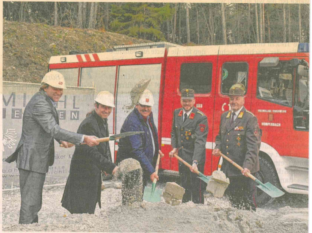
Hannes Kronthaler, Architekt Raimund Waibl, BM Hubert Hußl, FF-Kommandant Florian Gartlacher und Landesfeuerwehrkommandant Klaus Erler (v. l.) freuten sich beim Spatenstich über den Baubeginn.
