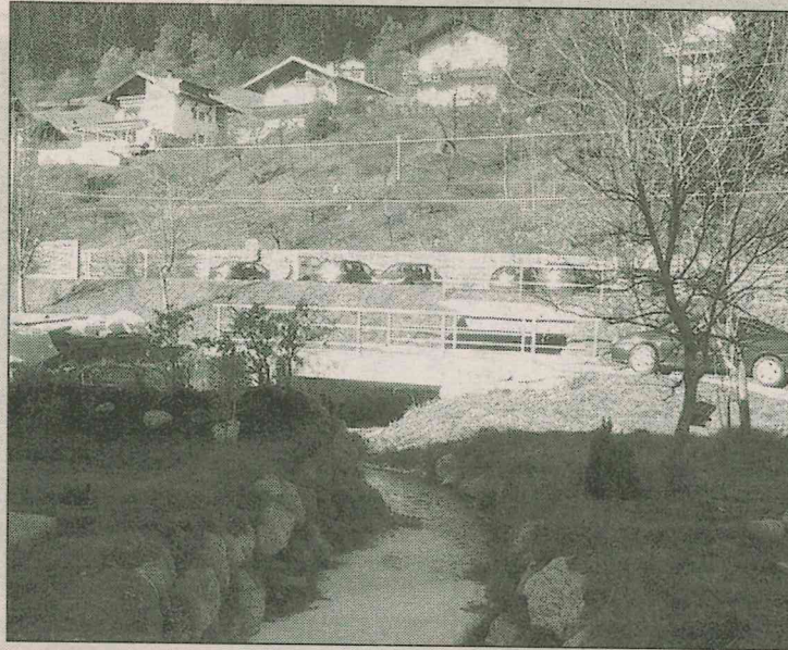
Der Ölfilm wurde an dieser Stelle des Riederbachls entdeckt.
