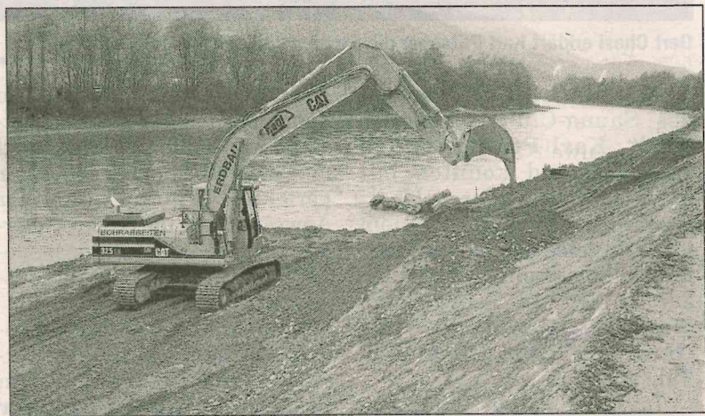
Die Bauarbeiten am Inn bei Fritzens dauern den ganzen Winter.
