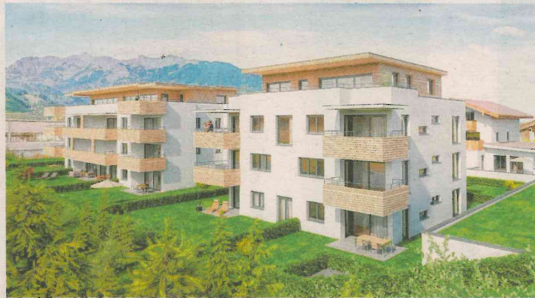
In Terfens entstehen derzeit 14 wohnbauförderte Eigentumswohnungen und 7 geförderte Mietkaufwohnungen. Visualisierung: Hörhager
