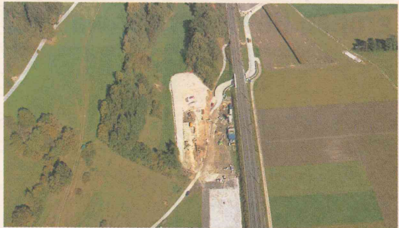
Die Bauarbeiten beginnen am Voreinschnitt in Terfens.
