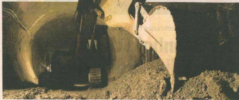
Der Tunnel zwischen Vomp und Terfens ist durchbrochen. Foto: BEG
