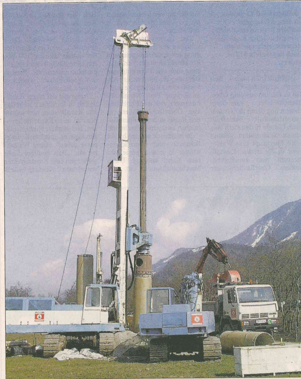
IN DER GEMEINDE STANS, wo die Trasse der Unterinntaltrasse bis Terfens in den Untergrund abtaucht, stehen derzeit diese Bohrgeräte. TT-Foto: Hörhager
