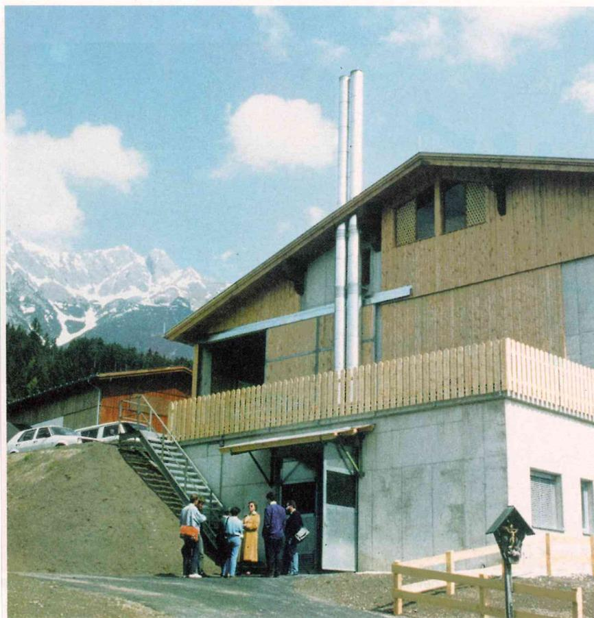
Im Heizhaus der Nahwärmanlage Terfens (Bild) sind zwei Unterschub-Feuerungskessel untergebracht. Ihre Heizleistung: je 350 kW. Das Heizwerk versorgt 23 Objekte ganzjährig mit Heißwasser. Verbrannt werden jährlich circa 3000 Schüttraummeter Hackschnitzel
