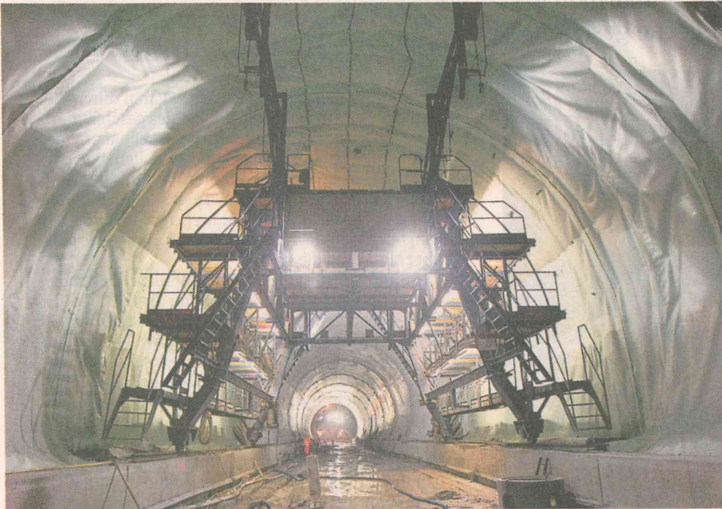
Der Basistunnel, Europas längster Bahntunnel, soll laut Plan bis 2022 fertig sein.
