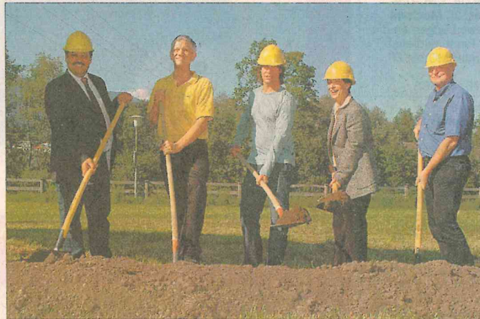
BM Hubert Hußl, Reinhard Huber (Land Tirol), Architekt Daniel Nocker, LR Anna Hosp und Klaus Juen (Land Tirol, v. l.) beim Spatenstich auf dem Stublerfeld.
