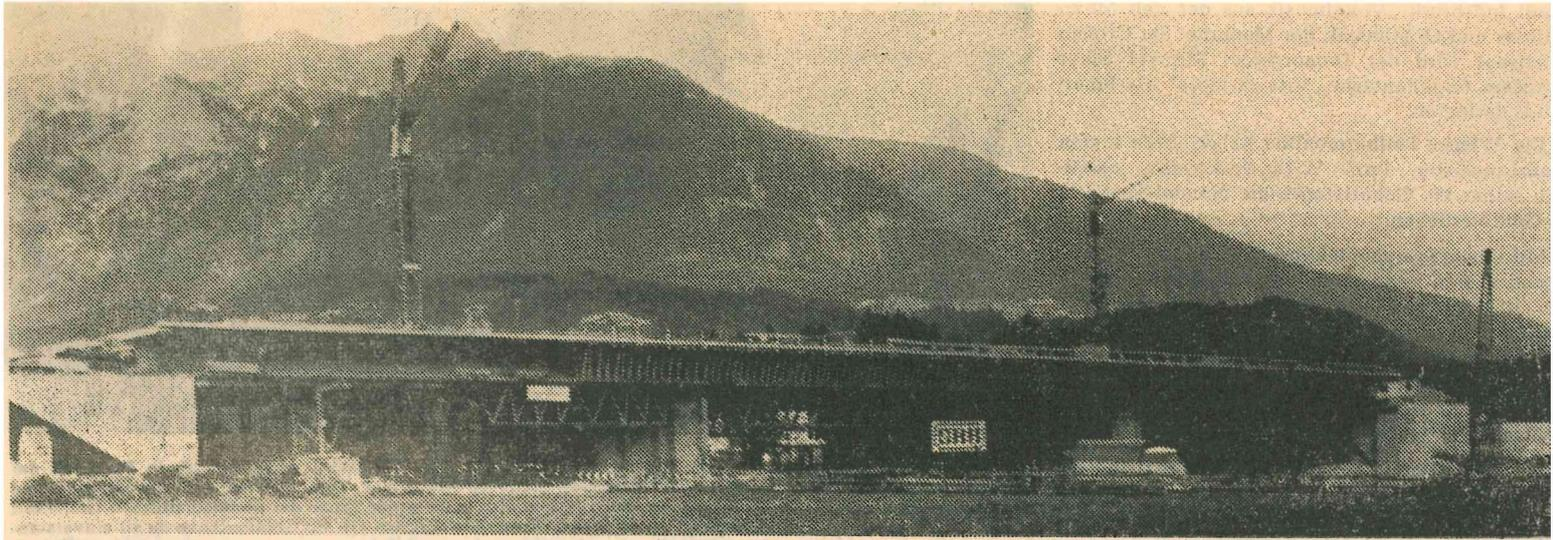
Beim Bau der Autobahnbrücke bei Vomperbach — unser Bild — wurde bereits das Schalgerüst wieder entfernt, Diese Strecke wird schon 1970 befahren werden können.
