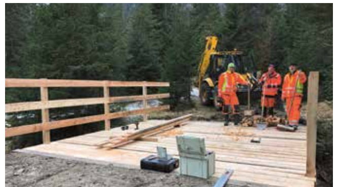
V.l.: Thomas Auer, Erwin Messner und Georg Arzberger bei der Instandsetzung der sechsten Loipenbrücke.
