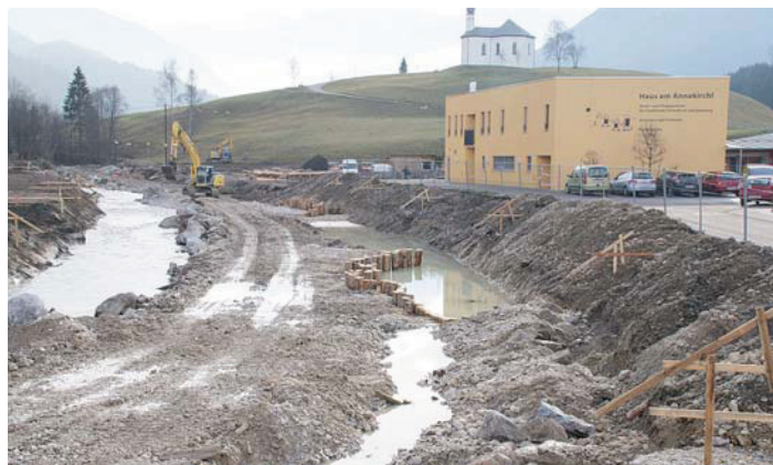
Projekt „Verbauung Seeache“ im Bereich Altenwohnheim.
