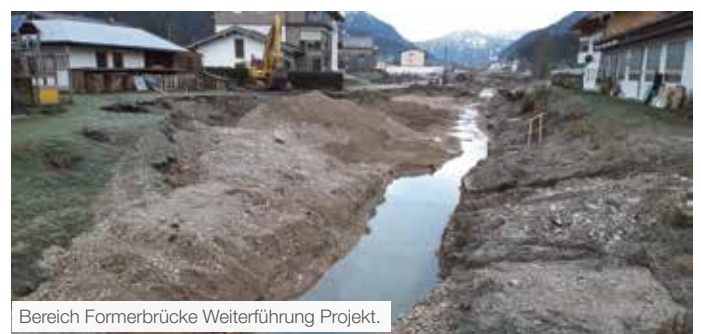
Die Baumaßnahmen beim Blaserbach sind größtenteils abgeschlossen.
