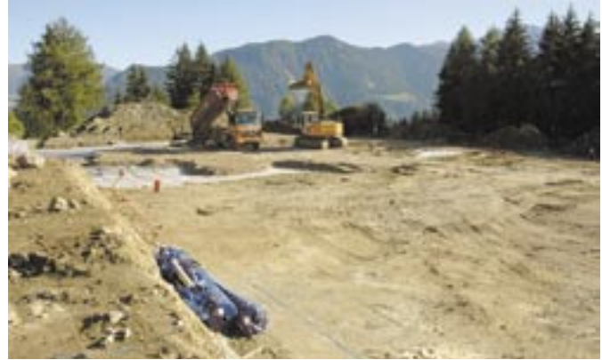
Aushubarbeiten für das Wohn- und Pflegezentrum in Eben
