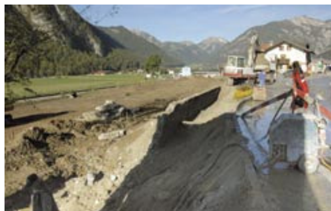
Bauarbeiten am Projekt Maurach Mitte
