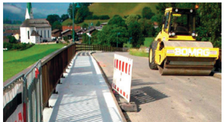
Gehsteigsanierung Brücke Rofansiedlung
